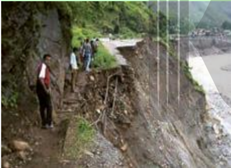
لغزش در اثر زیربری رودخانه در هند
