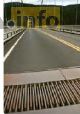
(ب) نمونه‌ای از بست انبساطی/انگشتی (پ) نمونه‌ای دیگر از بست‌های انبساطی
