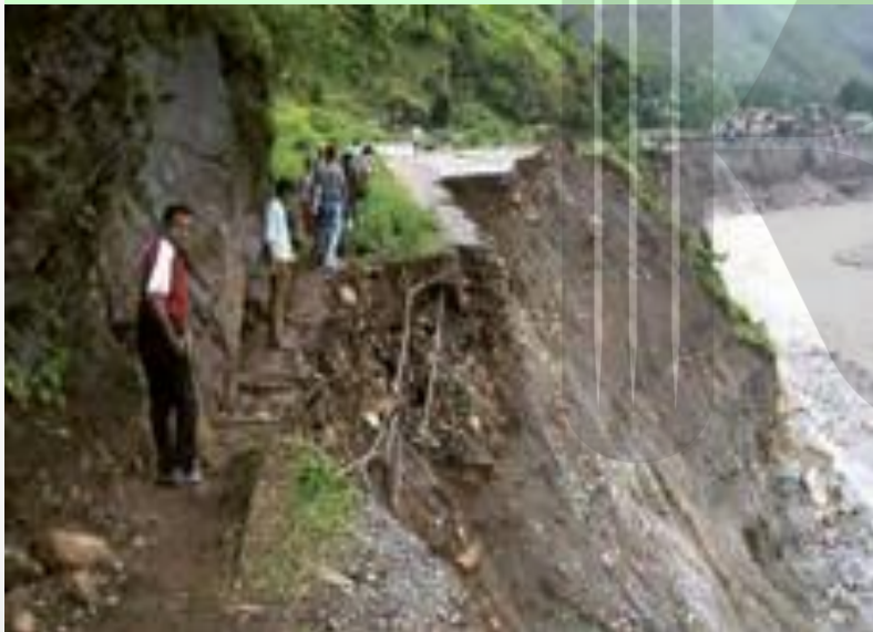
لغزش در اثر زیربری رودخانه در هند
