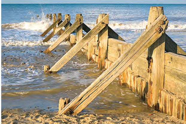
نصب حفاظ عمودی
