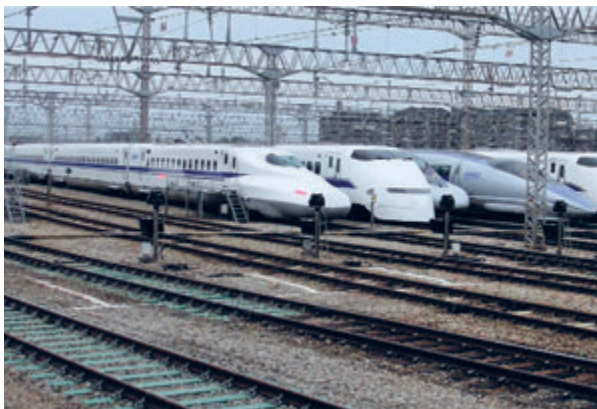
ایستگاه قطارهای پرسرعت - شینکازن - ژاپن
