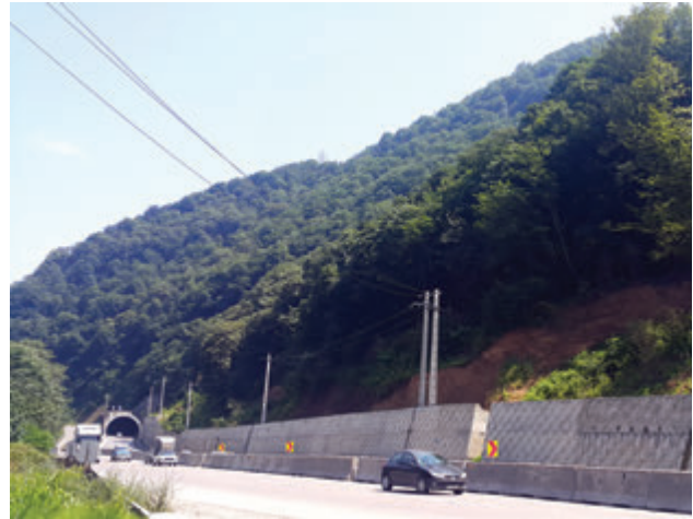
نصب حفاظ بتونی - جاده قائم‌شهر
